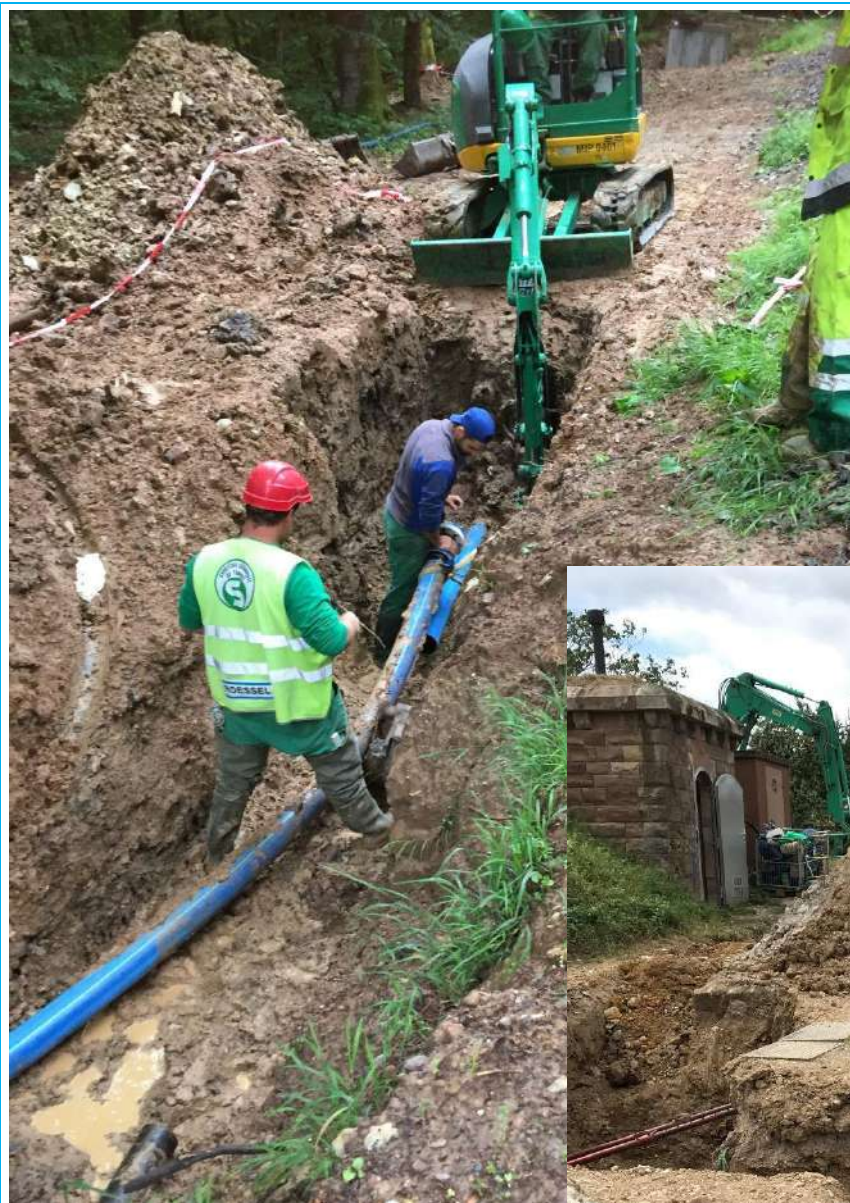
Renouvellement de la conduite de sources de Heiligenberg
