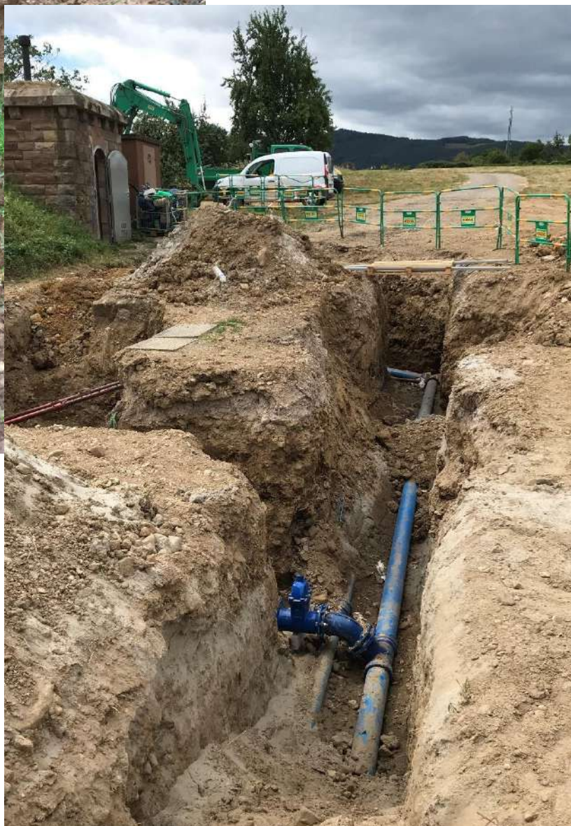
Renouvellement des conduites de distribution et de vidange du réservoir de Niederhaslach
